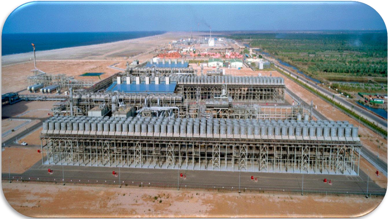
Egyptian LNG (ELNG) terminal, Egypt. Photo courtesy of BG Group.
